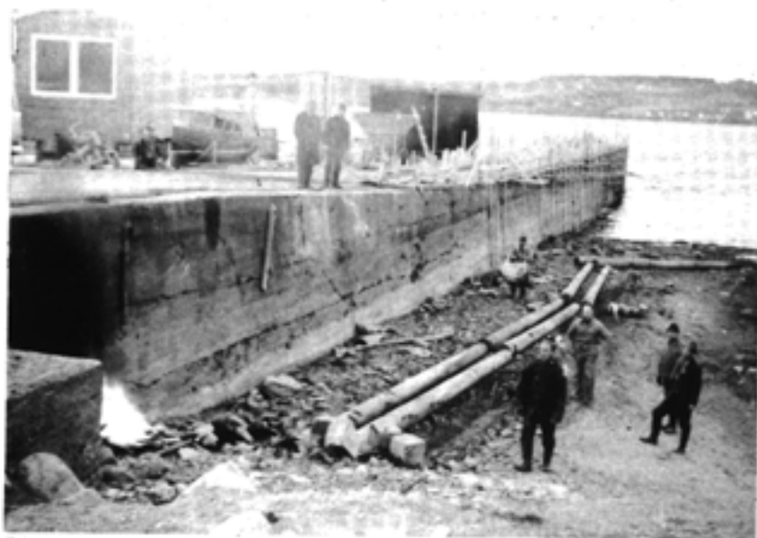
Båthavna i Gjøvik under anlegg 1967. Merk den lave vannstand
